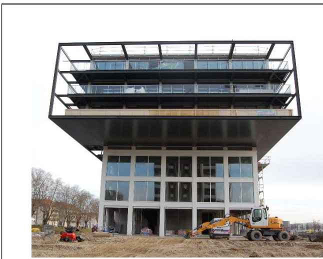
Vue du porte-à-faux (pignon ouest) (© Heintz-Kher architectes)
