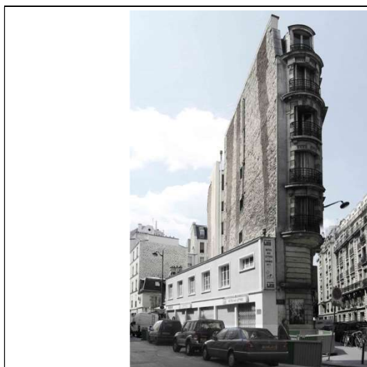
Bâtiment existant (©ZOOM FACTOR architectes)
